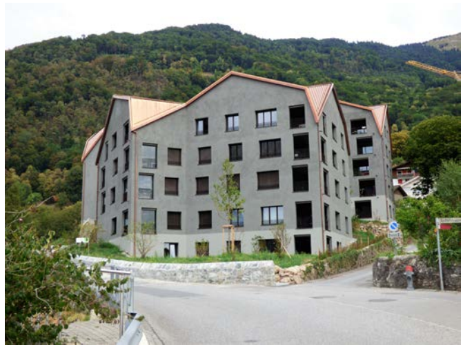
Neue Überbauung nach Fertigstellung 2018 (Foto, suisseplan)
