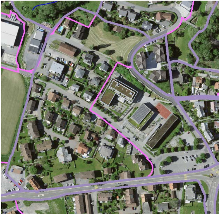
Luftbild 2019 (Quelle: Kanton SG)
