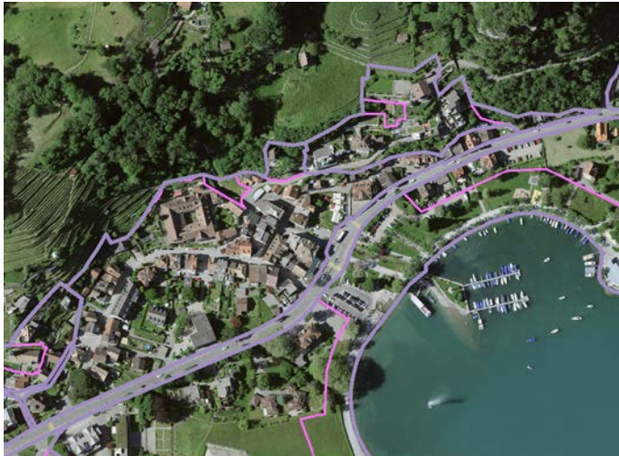
Luftbild 2019 (Quelle: Kanton SG)
