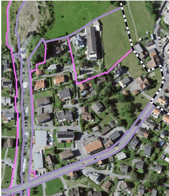
Luftbild 2019 (Quelle: Kanton SG)
