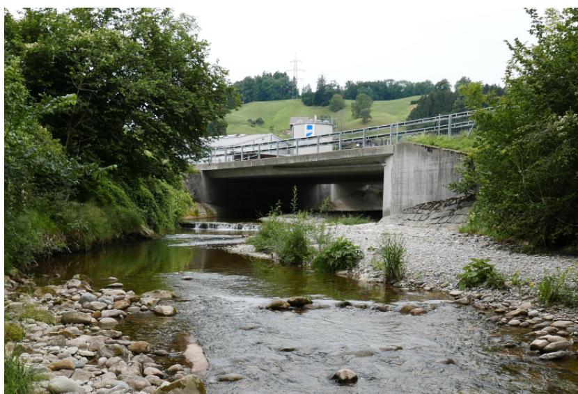
Bild 6 Brücke Zufahrt/Abfahrt A53 mit Schwelle unmittelbar bachabwärts davon und Kies- bank auf der Kurveninnen- seite. Blick gegen Fliessrich- tung.
