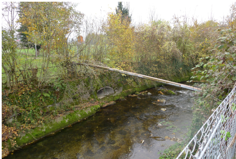
Bild 16 Einleitung Entwässerungskanal und Überquerung upc-Leitung. Blick in Fliessrichtung (km. 2.375).
