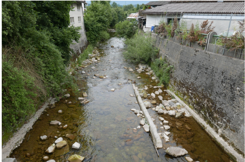
Bild 4 Aabach bachabwärts Brücke Kantonsstrasse. Blick in Fliessrichtung.
