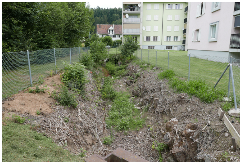
Bild 15 Entlang des linken Ufers verlaufender, auf Parz. 71 offen geführter Entwässerungskanal. Blick gegen Fliessrichtung.
