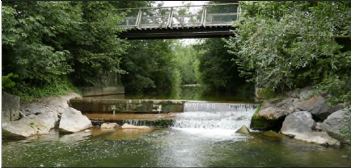
**Abbildung 15: Schwelle unmittelbar bachabwärts der Brücke Säntisstrasse mit einer harten Überfallkante, welche als nicht fischgängig eingestuft werden kann. (Quelle Foto: technischer Bericht, Entwurf, dat. 29.11.2024)**
