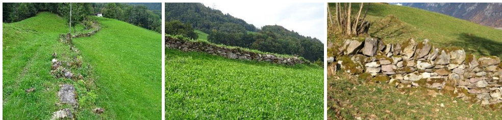
Trockenmauern in unterschiedlichem Zustand (Gebiet Höfli, Töbeli)
