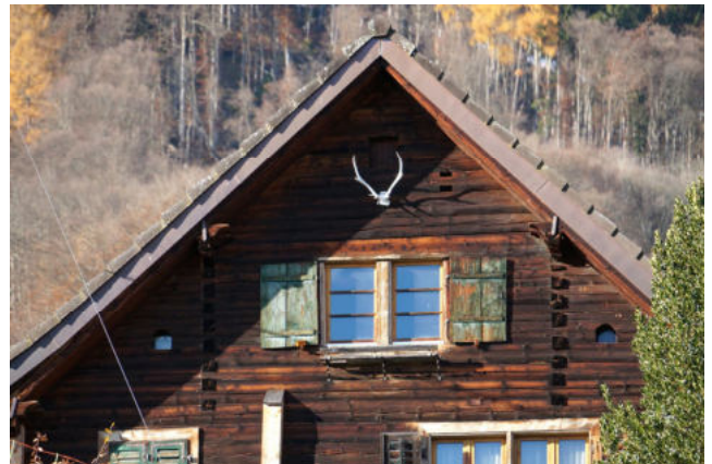
Giebeldreieck Hauptfassade mit offenem Strick
