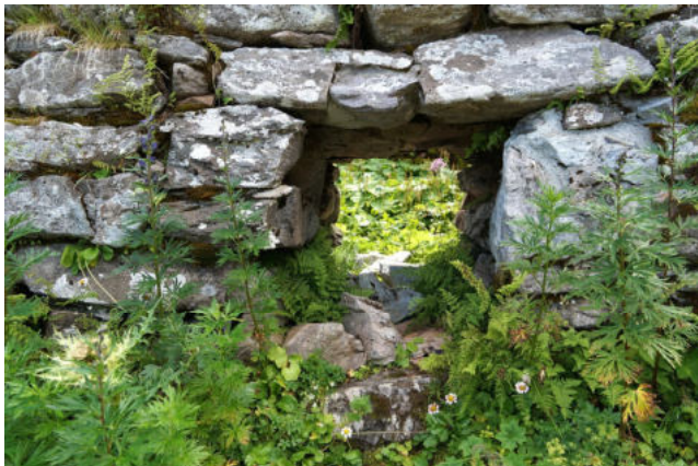
Feuerloch an der Nordseite
