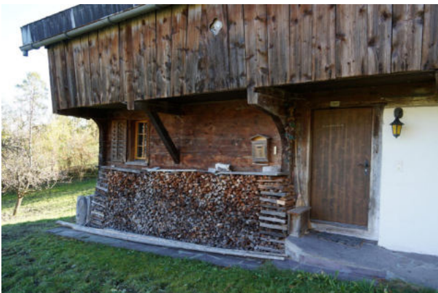
Ansicht Westseite mit Eingangsbereich und Holzlaube
