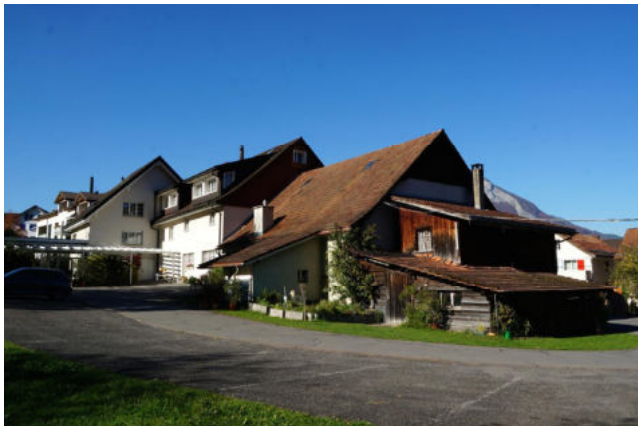
Rückwärtige Ansicht (von Süden)
