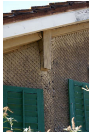
Durch Holzschindeln verkleidete Strickbaukonstruktion
