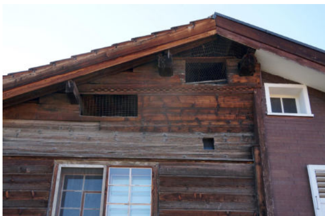
Hauptfassade Kernbau mit Würfelfries und "Seelabalgga"
