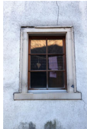
Fenster im gemauerten Hausteil
