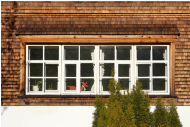
Vierteiliger Fensterwagen Südostfassade
