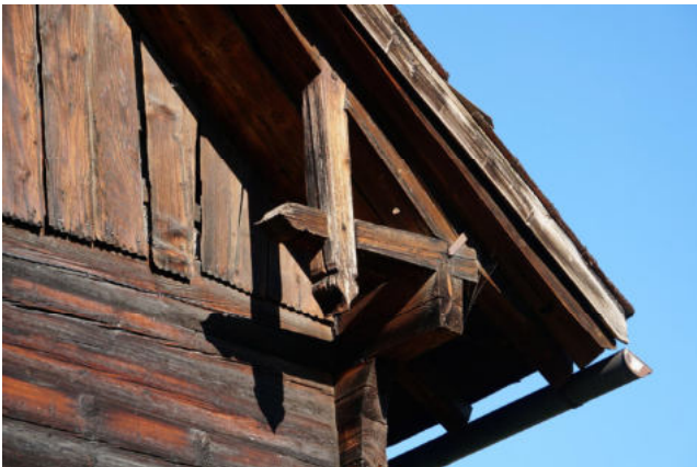
Pfettenvorsprung mit Flugdreieck
