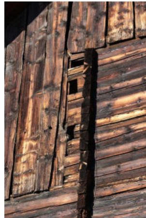
Übergang von Strickbau zu verschalter Ständerkonstruktion
