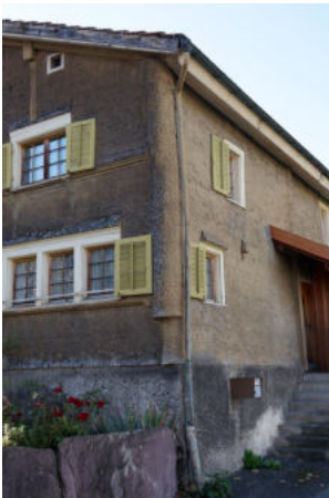
Herumgezogene Holzschindelung (nordöstliche Hausecke)
