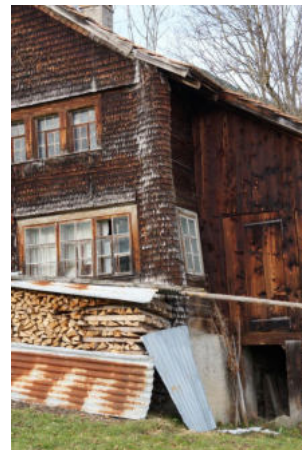
Herumgezogene Schindelung an der nordöstlichen Hausecke
