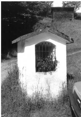
Bildstock vor der Restaurierung (Foto: Siedlungsinventar 1992)
