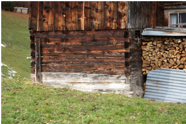
Strickunterbau Anbau Süd
