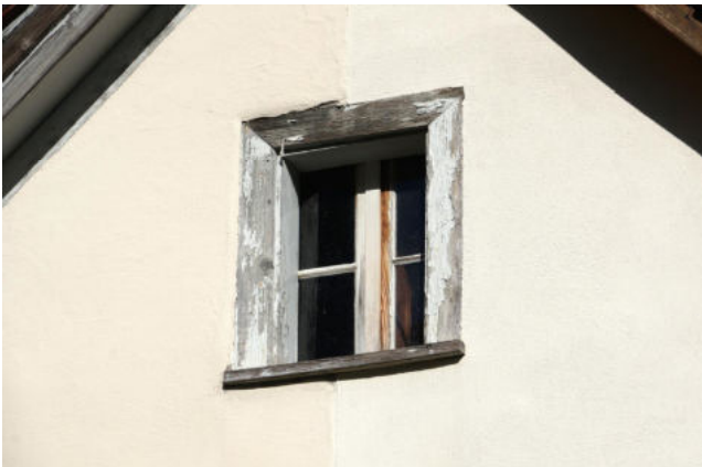
Oberstes Fenster beim Giebelndreieck
