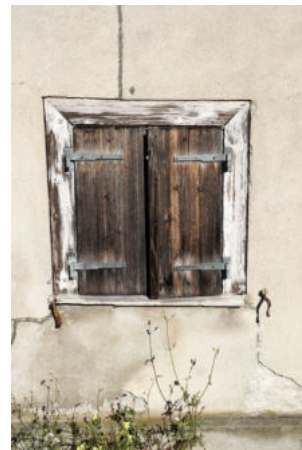
Fensterlösung im gemauerten Gebäudeabschnitt Ass. 875
