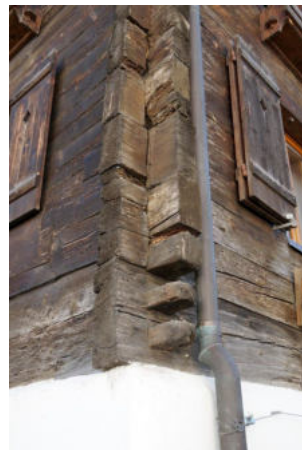
Strickkonstruktion
