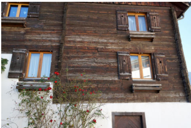
Strickbau mit massivem Sockelgeschoss
