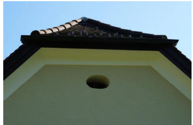
Krüppelwalmdach mit ovaler Öffnung beim Giebel
