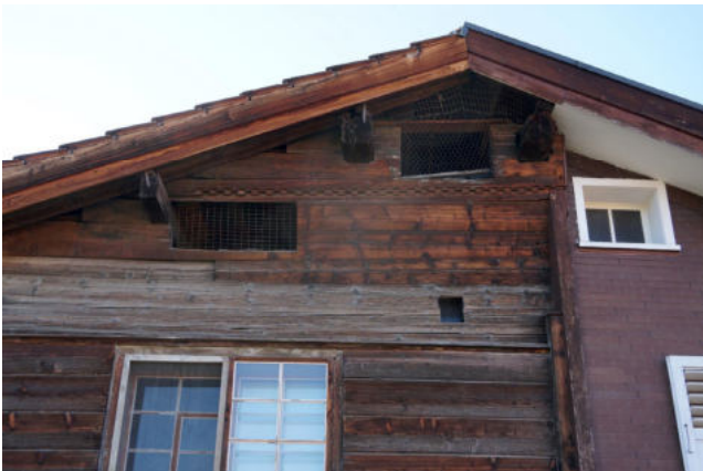
Hauptfassade Kernbau mit Würfelfries und "Seelabalgga"
