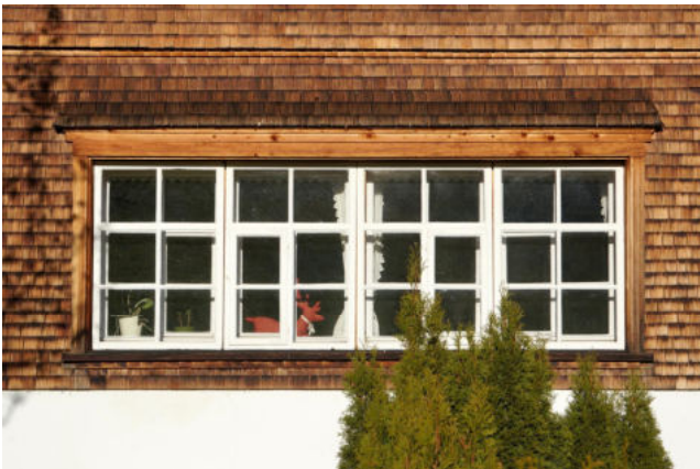
Vierteiliger Fensterwagen Südostfassade
