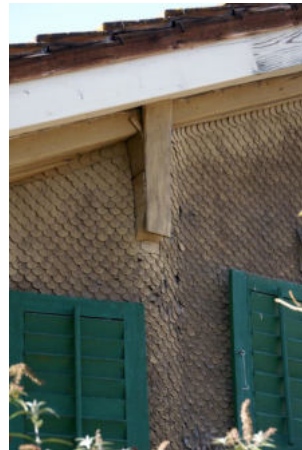
Durch Holzschindeln verkleidete Strickbaukonstruktion
