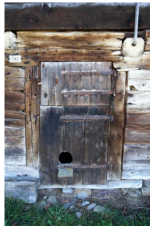
Zugang zum ehem. Stall auf der Nordostseite
