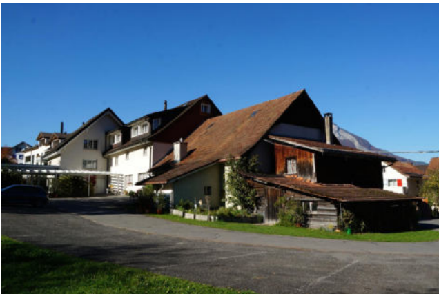
Rückwärtige Ansicht (von Süden)
