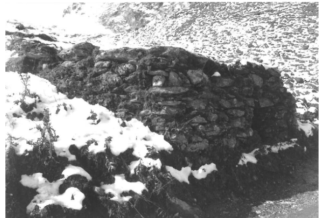
Ansicht vor der Instandstellung 1998
