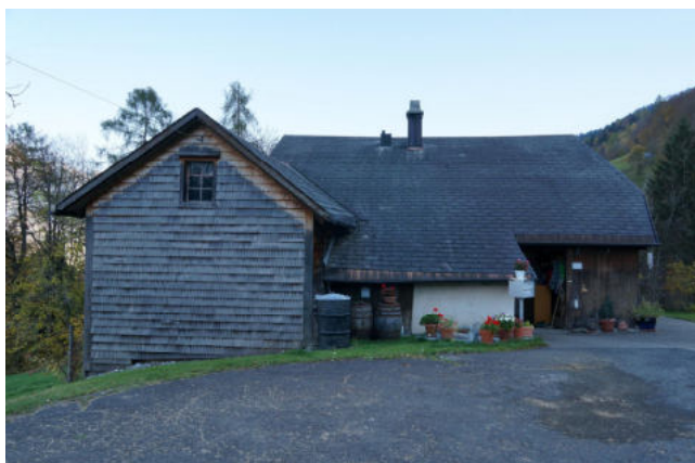
Ansicht strassenseitig (von Westen) mit angebautem Sticklokal
