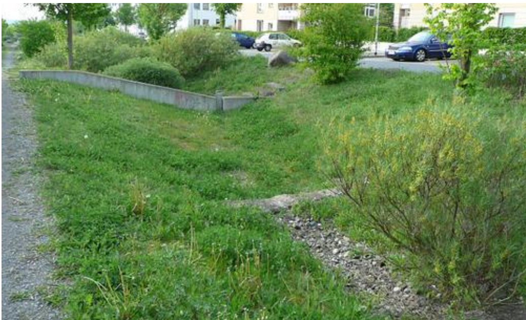
Abbildung 5: Mulden und Rigolen als mögliche Retention und Versickerungen
