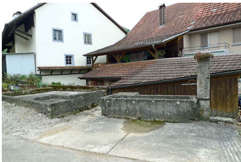
Ansicht von Osten (2010)
