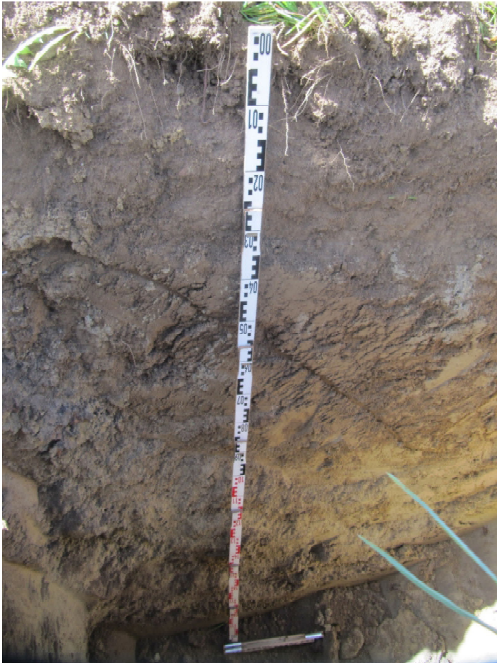
Abbildung 6: Baustelle «GAP Sefar», Baggerschlitz 3. 11.04.2018: Foto: KBA.
