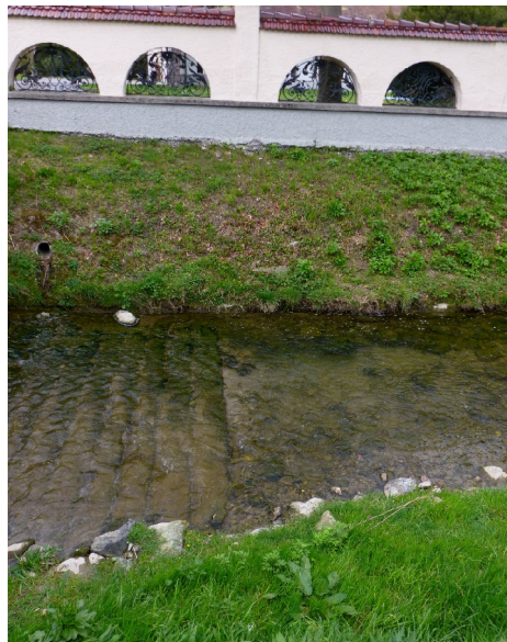
Abb. 3: Kurz unterhalb der Sefar-Brücke wechselt die Sohlenbeschaffenheit von durchgehendem Steinsatz zu einer Natursohle aus Kies und Stein.
