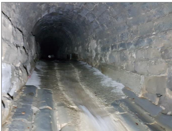
Schadenstelle Sohle, 2016 repariert
