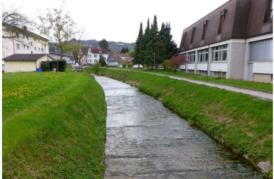
Abb. 2: Freibach mit sehr steilen Böschungen im oberen Abschnitt des Projektperimeters
