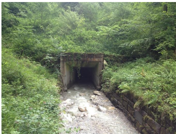
Einlaufbauwerk Durchlass
