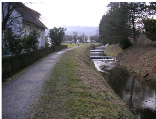
Abb. 2: Freibach unterhalb GAP
