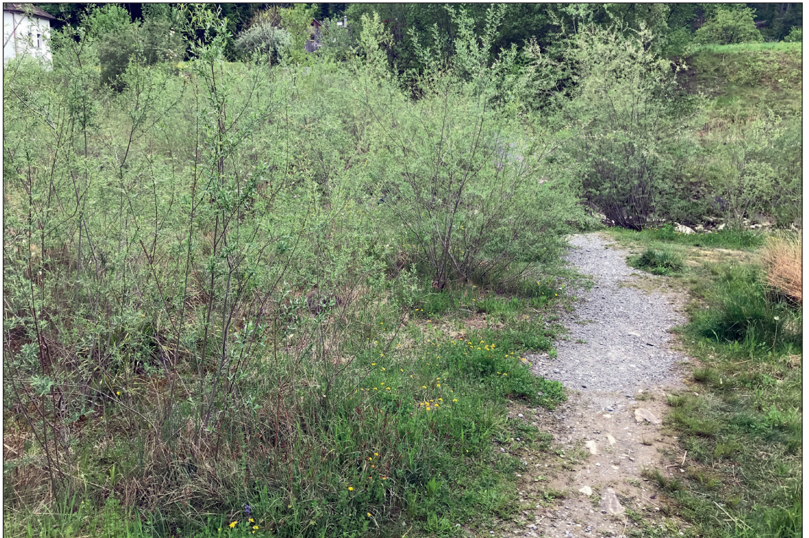
Geschieberückhaltebecken Dürrenbommert Berneck.
