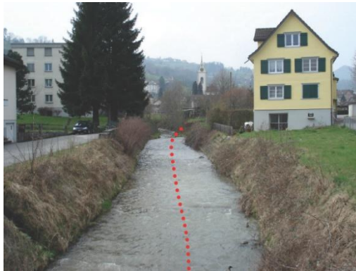
Abb. 4: Freibach von Brücke Töberstrasse (Blick gegen Fliessrichtung, Foto Gruner+Wepf, rote Linie: Achse)
