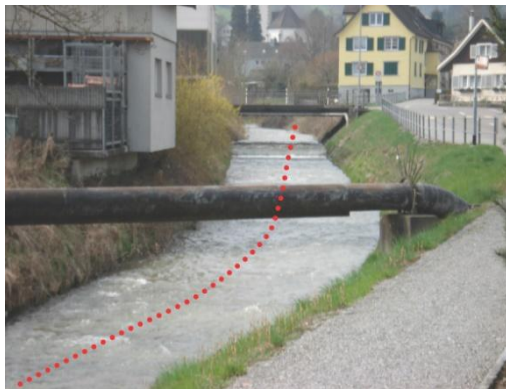
Abb. 6: Freibach Rohrbrücke bei km 1.27 (Blick gegen Fliessrichtung)
