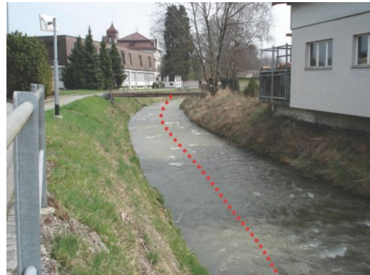
Abb. 5: Freibach von Brücke Töberstrasse (Blick in Fliessrichtung)
