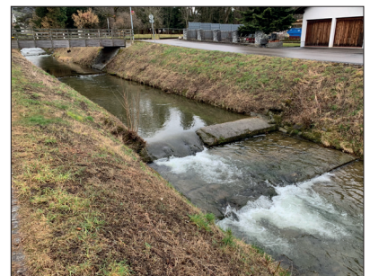
Zur Optimierung der Längsvernetzung wurden Schwellen fischgängig gestaltet. Das Gerinne selbst bleibt strukturarm (M.Schaer).
