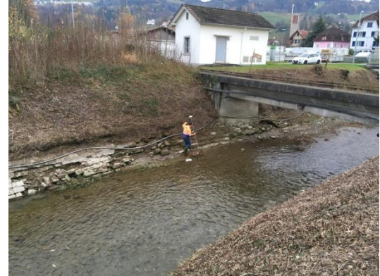
Schadhafte Böschungssicherung Ufer rechts (gegen Fließrichtung)
