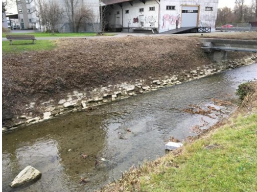
Schadhafte Böschungssicherung Ufer links (in Fließrichtung)
