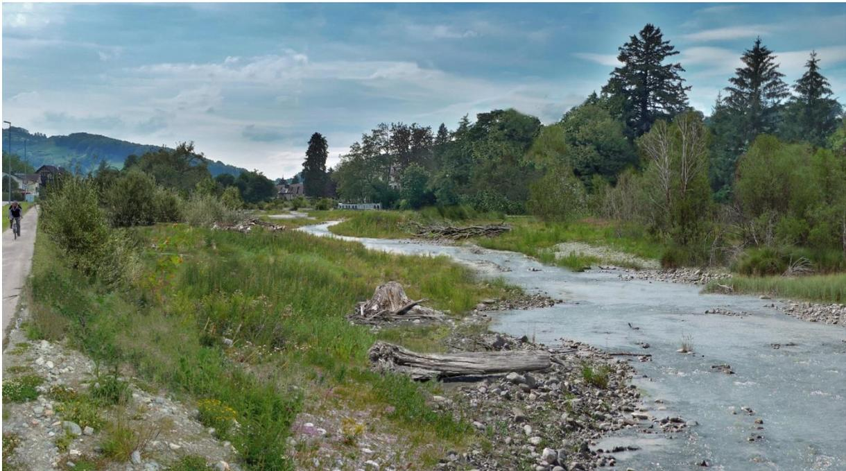
Bildlegende: Die Dimension des Geschiebeablagerungsplatz wurde so gewählt, damit ein statistisch gesehen alle 100 Jahre stattfindendes Hochwasser schadlos abgeleitet und das mitgeführte Geschiebe zurückgehalten werden kann. Visualisierung: Hydra AG
