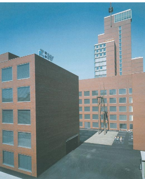
Das Swisscom-Hochhaus in Winterthur (Burkard Meyer Architekten).
