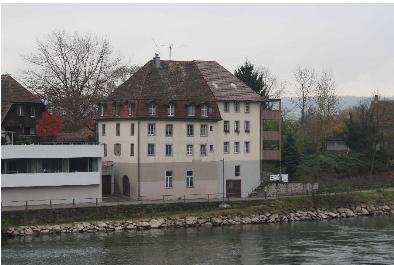
Ansicht von Nordosten (2019)
