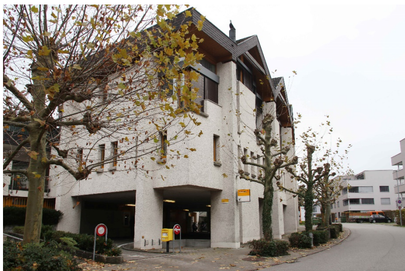
Ansicht an der Pilatusstrasse von Nordwesten (2019)
